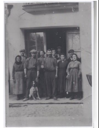
Forge de JEAY Place du 11 novembre, actuellement Maison du patrimoine
